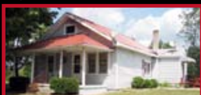
2165 Thompson Hill, Otway
